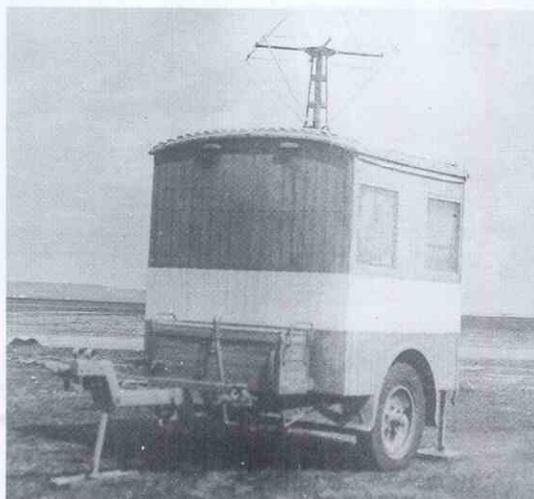
Movil portador de un equipo transmisor-receptor de frecuencia media (MDF), para control de operaciones en aeródromos. En el de Alcalá de Henares hubo un equipo de estas características, en las décadas de los años 40 y 50.
