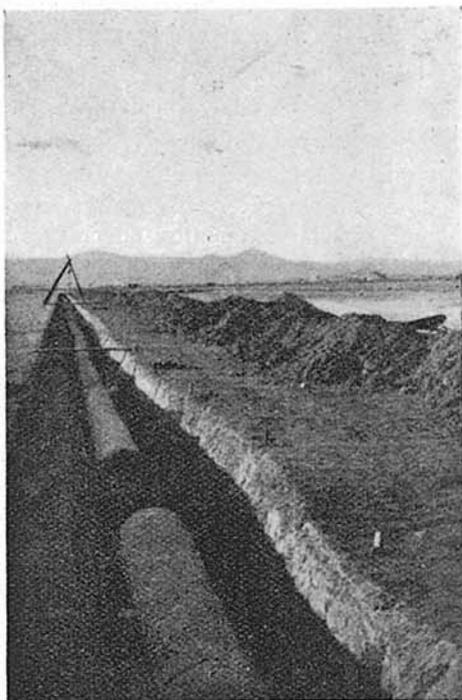
*Tubo colocado en la zanja de drenaje, según tercer proyecto.*
