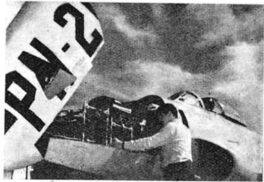
*Detalle de la instalación en un F-80 de una cámara K-30 para reconocimiento fotográfico a gran altura y velocidad.*
